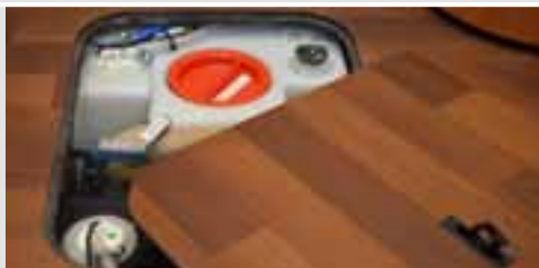
Accesso di servizio ai serbatoi
