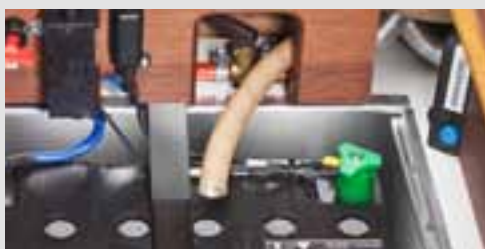
Riscaldamento mirato dei componenti degli impianti
