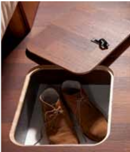
Vani scarpe nel doppio pavimento riscaldato
